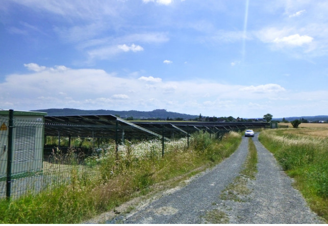
Abb. 48 Solarpark an der A73
