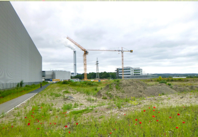
Abb. 43 Baustellenfläche im Süden
