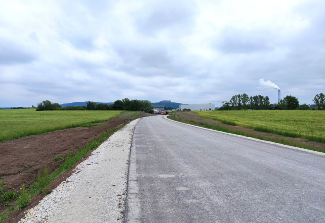
Abb. 47 Neu gebaute Staatsstraße ST2205
